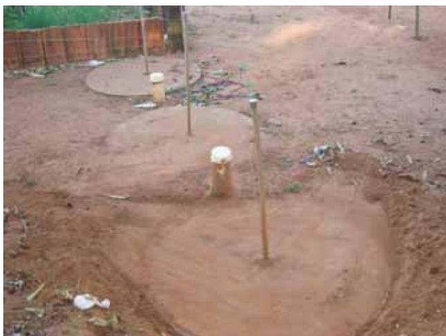
**Figura 16 – Fossa séptica biodigestora construída com incentivos do PEMH – propriedade rural na Microbacia do Ribeirão Alegrete – Martinópolis/SP (2009)**
