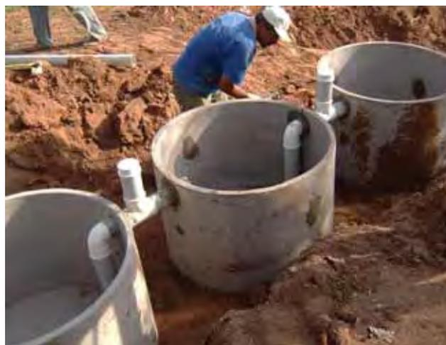
**Figura 17 – Construção de fossa séptica biodigestora em propriedade rural no Município de Santo Expedito/SP (2008)**
