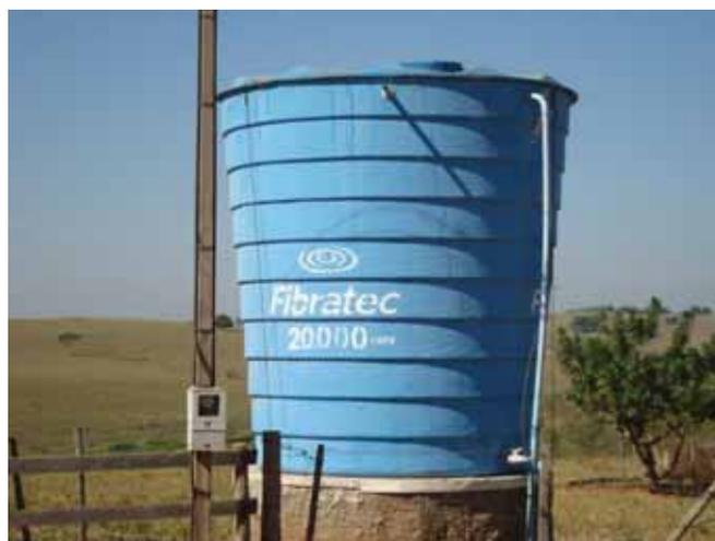
**Figura 11 – Modelo-padrão do poço e abastecedor comunitário adquirido e instalado através dos incentivos do PEMH – propriedade rural Microbacia Hidrográfica Córrego Jacutinga, Santo Expedito/SP**
