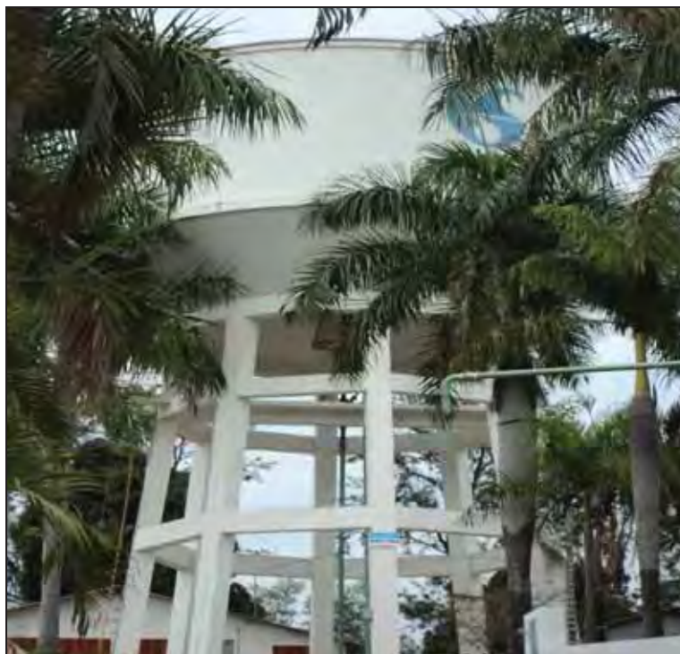
Figura 6: Reservatório da Sabesp, com capacidade de armazenar 600 mil litros. Fonte: Ana Carla Zeni, ago/2012.
