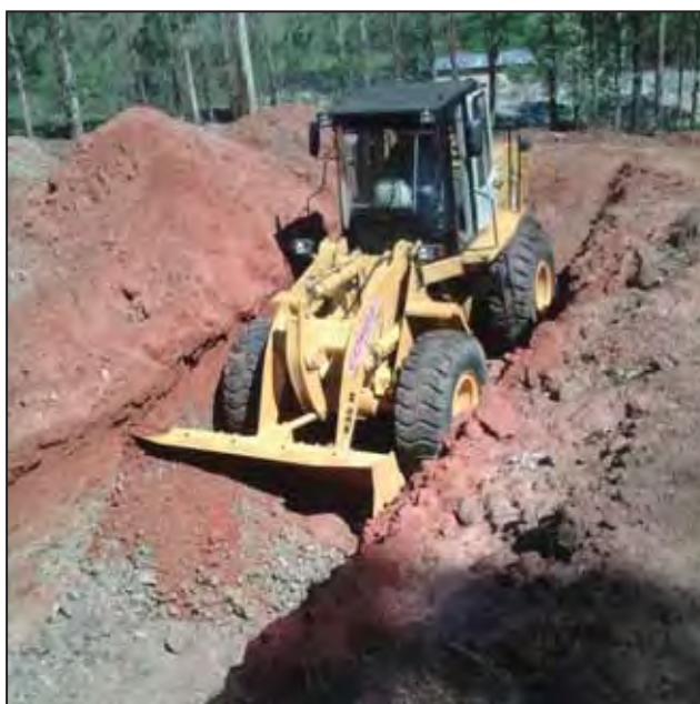
Figura 22: Abertura da vala para a disposição dos resíduos sólidos.
