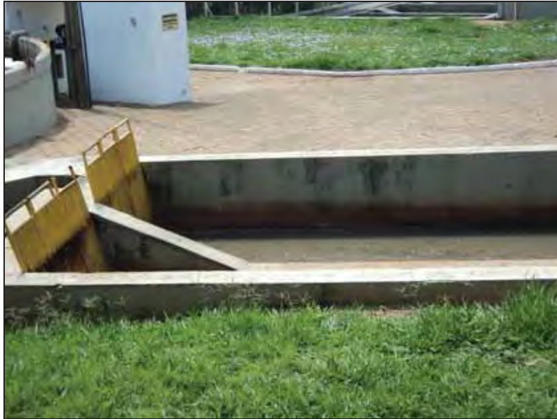
Figura 11: Desarenador com gradeamento. Fonte: Ana Carla Zeni, ago/2012.
