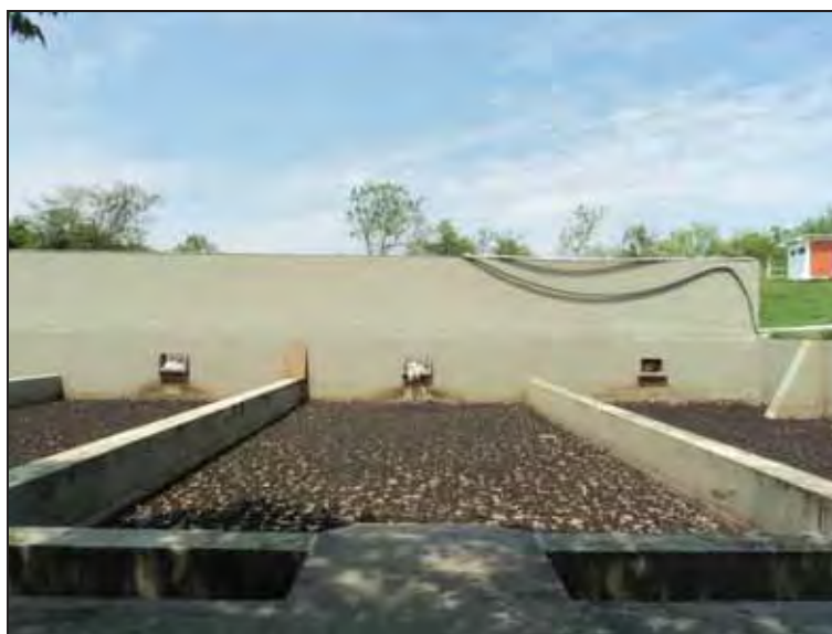
Figura 14: Áreas de secagem do lodo já estabilizado. Fonte: Ana Carla Zeni, ago/2012.
