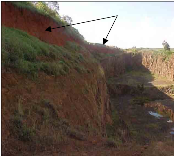
Foto 36. Processos erosivos no alto da cava
