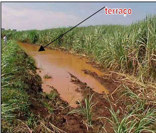
Foto 11. Depósito de sedimentos e água ao longo do terraço
