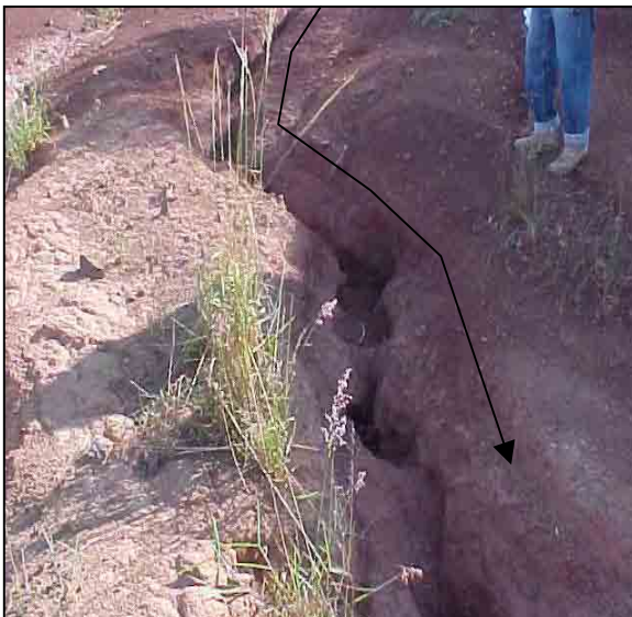
Foto 38. Detalhe de um sulco erosivo profundo próximo à cava
