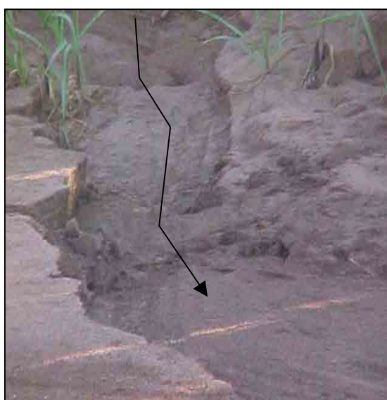
Foto 8. Detalhe de um sulco erosivo próximo ao canavial
