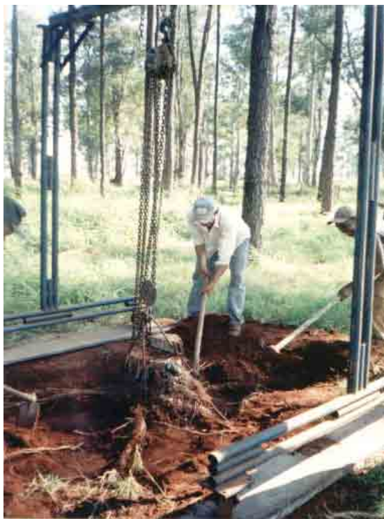
Figura 6: Tentativa de remoção do sistema radicular das árvores por meio de talha.
