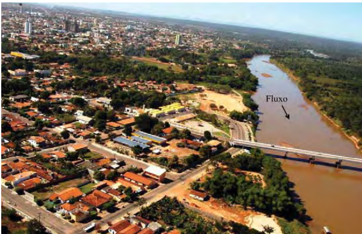
Figura 18 – Rio Vermelho contornando a cidade de Rondonópolis no início do segmento I. Apresenta características de canal retilíneo com barras de centro e alternada. Localização: 16°28'40" S e 54°38'08" O.
