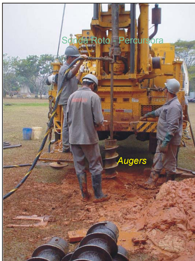
Foto 6 – Detalhe da sonda roto-percussora ( hollow stem auger ) sobre o caminhão, em operação no Campus da UNESP.
