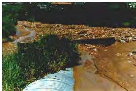
Foto 25 - Detalhe de depósito de assoreamento, soterrando a tubulação da galeria pluvial. Local: córrego junto aos bairros Jardim Bandeirantes e São Miguel. Ponto RC - 42.
