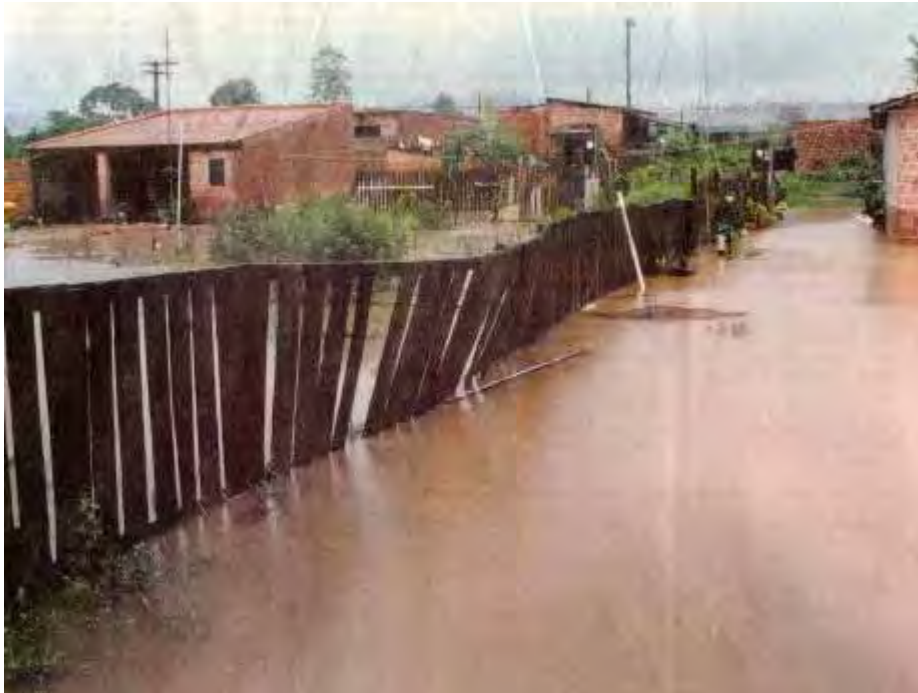
Foto 26 - Planície aluvionar do rio Corumbataí (Unidade VI) com registro de inundação. Local: Jardim Nova Rio Claro, zona sudoeste.
