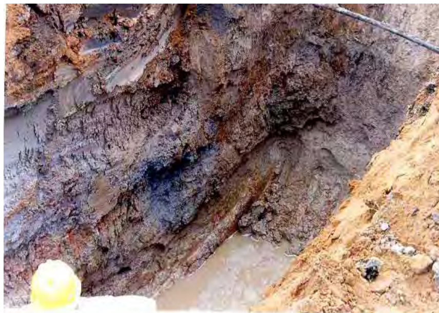
Foto 19 - Escavação, expondo o perfil de solo hidromórfico argiloso, com N.A. a cerca de 2 m da superfície. Local: Av. 24-A, próximo ao córrego Lavapés. Ponto RC - 46.
