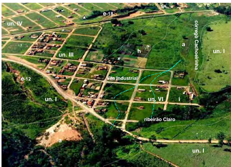
Foto 24 - Vista panorâmica mostrando as faixas de ocorrência das unidades geológico-geotécnicas I, III, IV e VI, com as seguintes características: boçorocas (e), depósitos de assoreamento (a), áreas sujeitas a inundações (i), ocorrência de solo hidromórfico e orgânico (h). Destaque para a porção do bairro, hoje desapropriada, localizada na planície de inundação, com os antigos leitos do córrego Cachoeirinha assinalados em azul. Local: Vila Industrial, zona norte de Rio Claro.
