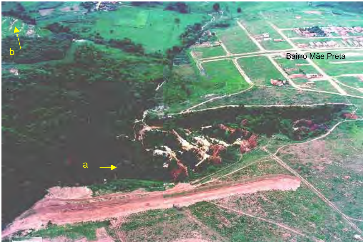
Foto 10 - Vista aérea de boçoroca em a (Unidade III/ sub-unidade III-A), no Bairro Mãe Preta, zona norte da cidade. Ponto RC- 5. Boçoroca (e-17, Anexo 4) aterrada com fibra de vidro em b. Fonte: Prefeitura Municipal de Rio Claro, novembro/90.
