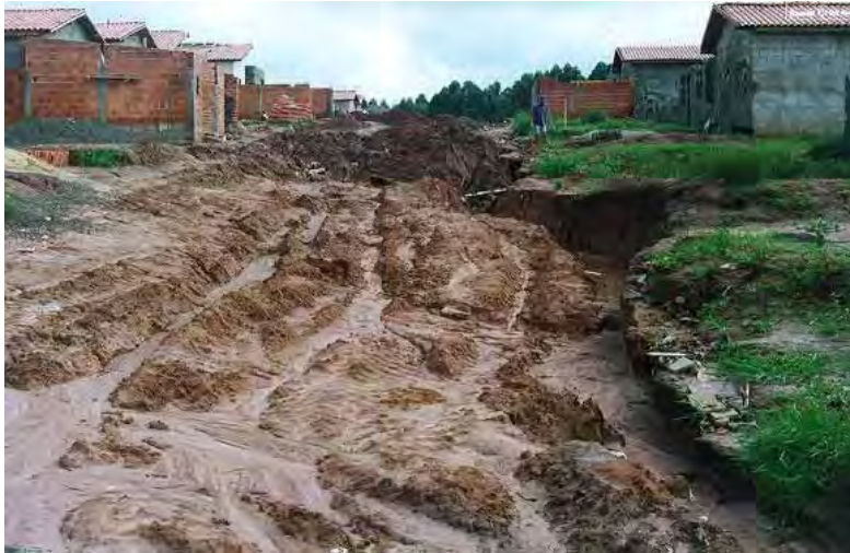
Foto 20 - Erosão em sulcos em ruas não pavimentadas na transição da sub-unidade IV-B para a Unidade III.
