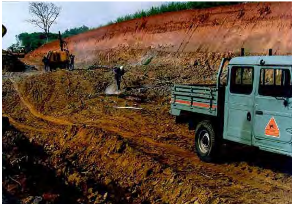
Foto 9 - Instalação de explosivos em diabásio (Unidade II), sub-aflorante na SP-127, a sul da área, à época da duplicação da rodovia (novembro/97).
