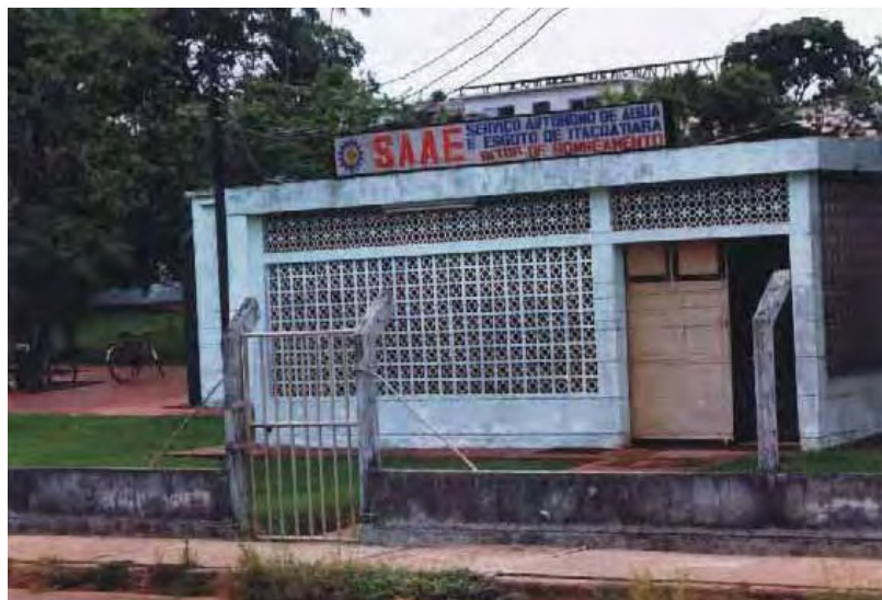
Figura 17. Prédio onde a água dos poços é clorada para o consumo da população de Itacoatiara - AM - 2000.
