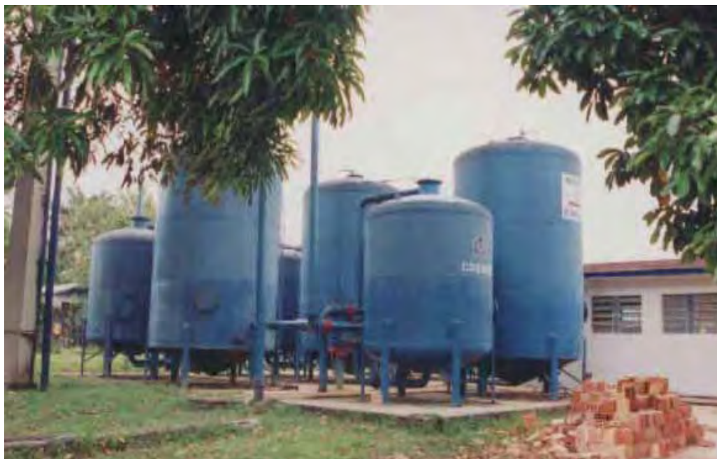
Figura 01. Complexo para tratamento de água desativado na cidade de Tefé - AM - 2002.
