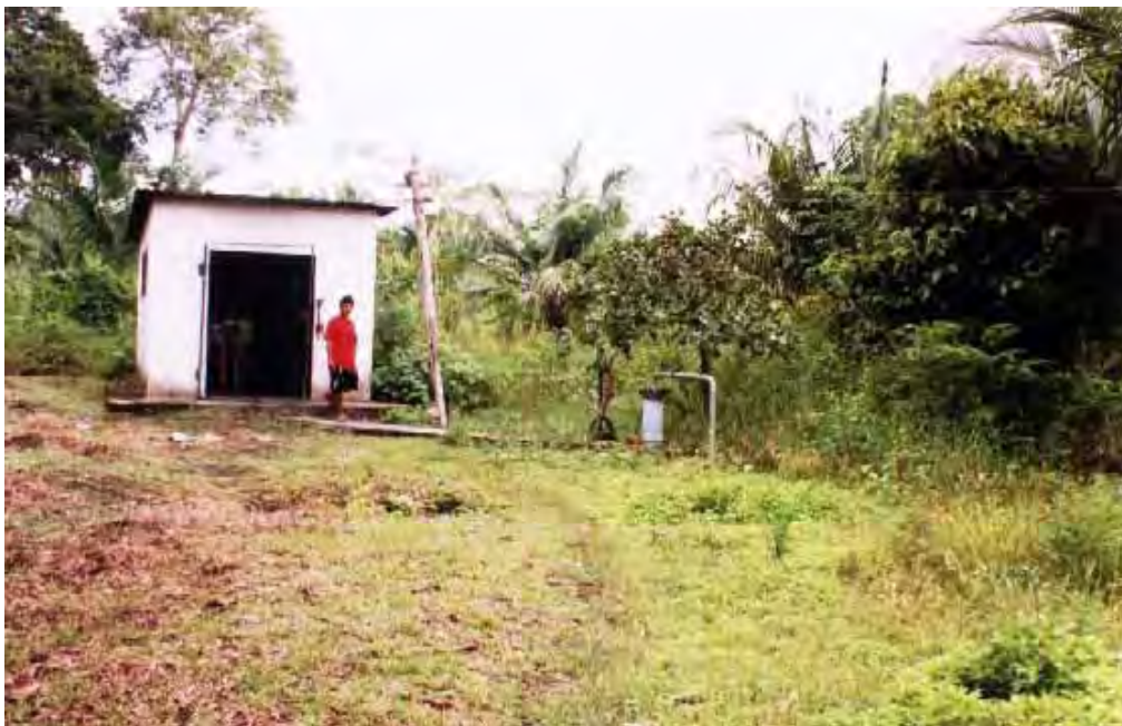
Figura 80. Coleta de amostra em poço tubular em vila Canarana - Maués - AM - 2002.
