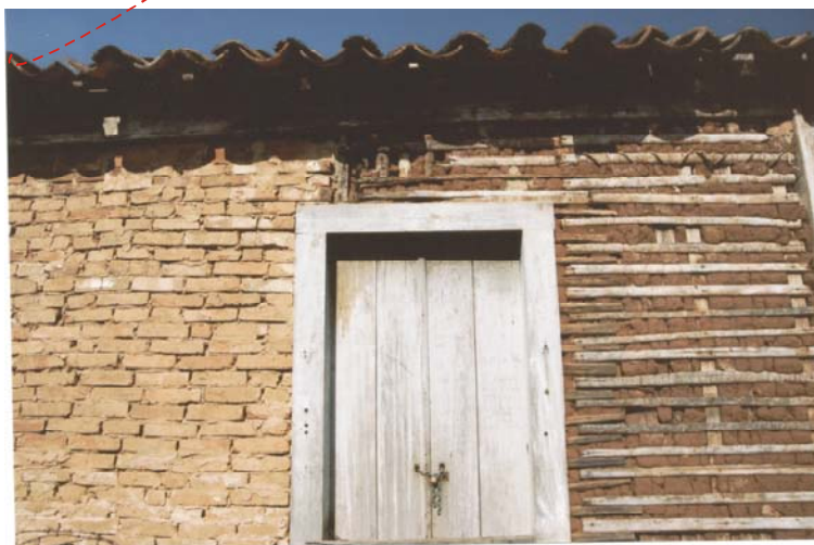
Foto 10: Detalhe da construção em pau a pique.
