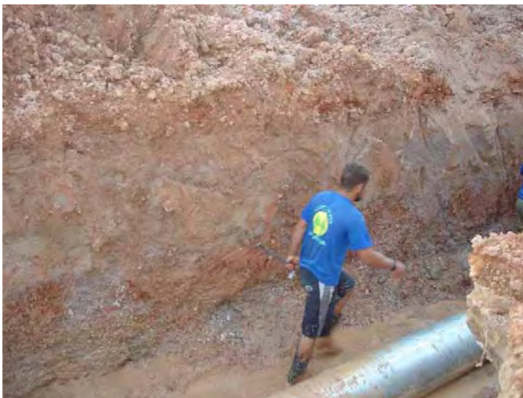
Figura 5.37: Foto de escavação realizada na Rua São Luiz com detalhe da presença de seixos e matriz areno-siltosa.
