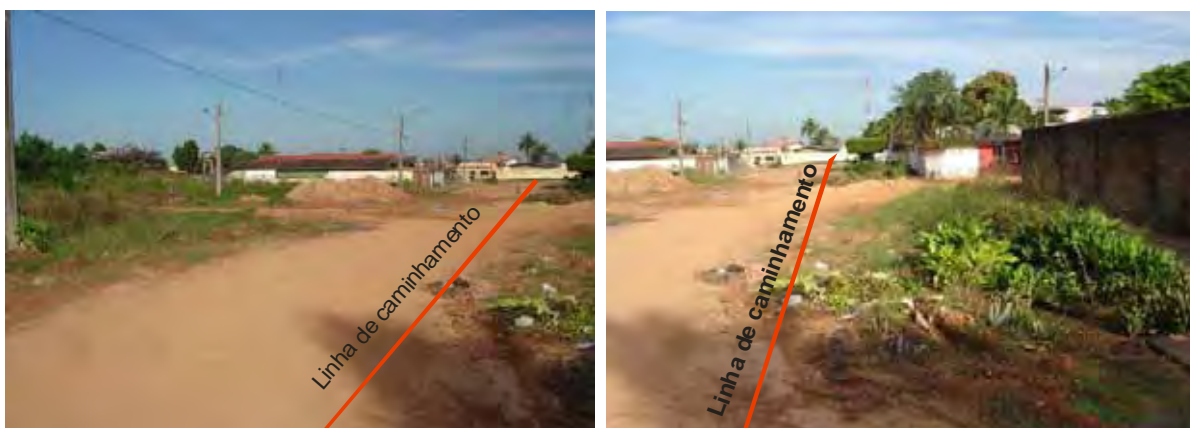
Figura 5.36: Fotos da Rua São Luiz, entre as Ruas T-2 e T-3 com escavação realizada pela CAERD ao fundo.
