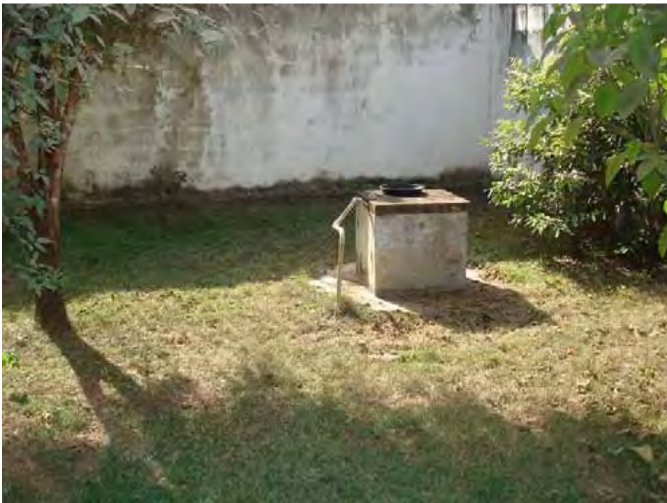
Figura 5.27: Foto do poço NBE-20.
