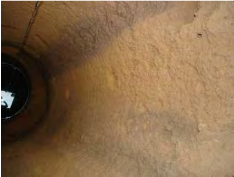
Figura 5.26: Foto do interior do poço NBE-15.
