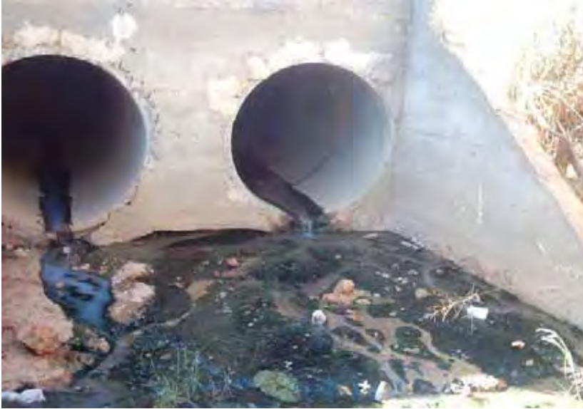
Figura 2.6: Detalhe de flagrante de lançamento de esgoto no Igarapé Pintado.
