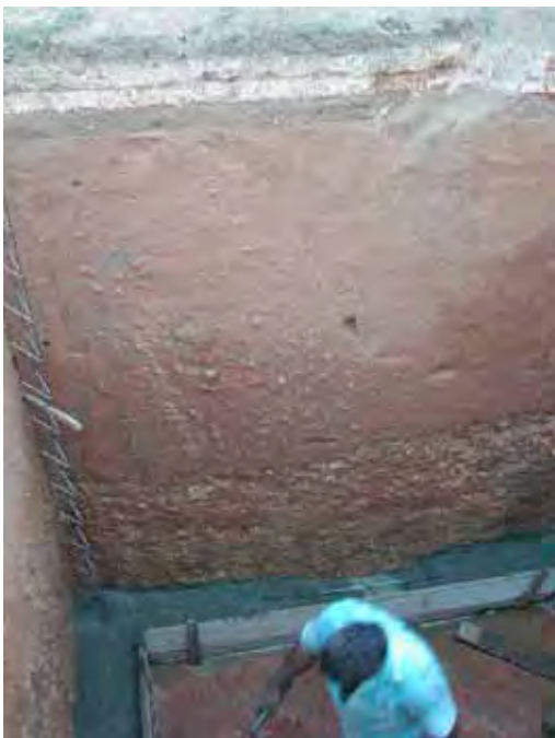
Figura 2.8: Foto de uma fossa negra sendo construída no Bairro Nova Brasília.
