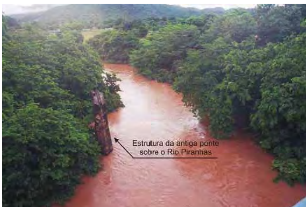
Figura 3.2 - Estrutura da antiga ponte sobre o rio Piranhas
