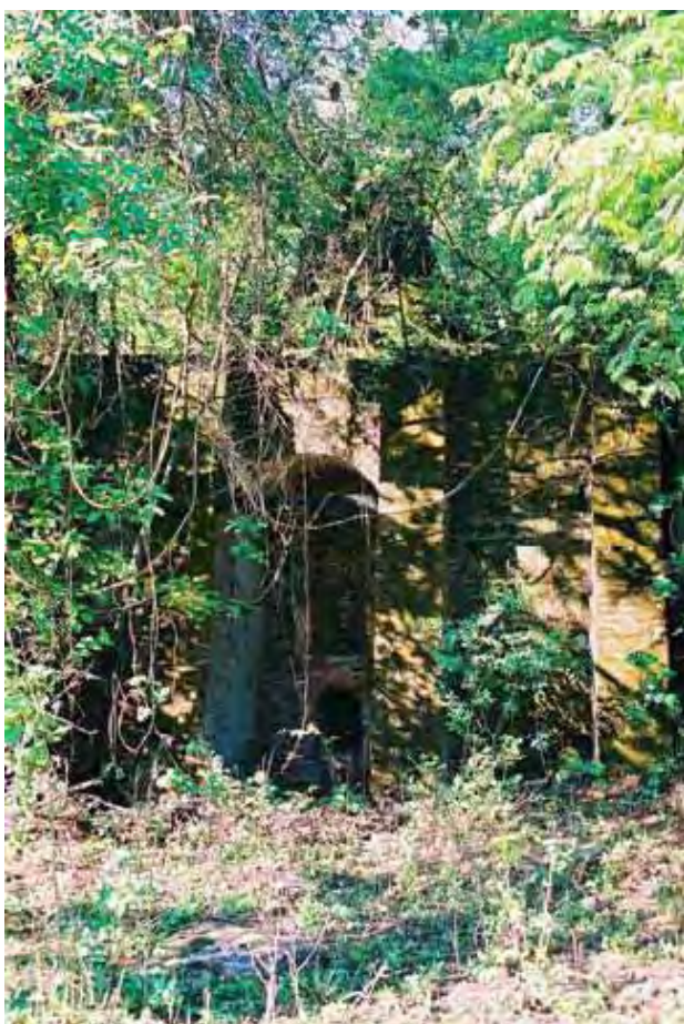
Figura 3.1 - Remanescente de antigo forno para cal (caieira). Município de Piranhas
