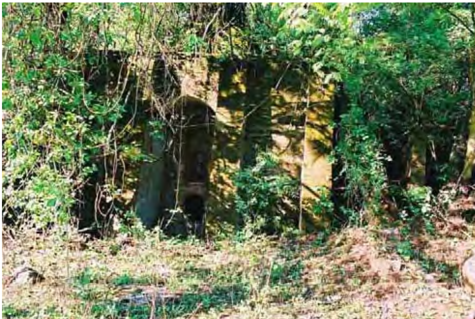
Figura 5.16 - Vista do antigo forno de cal utilizado pela Fundação Brasil Central
