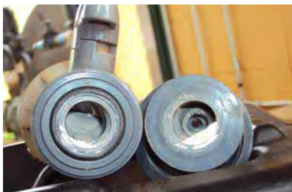
FIGURA 20. Registro desmontado para a limpeza, decantação de cal.
