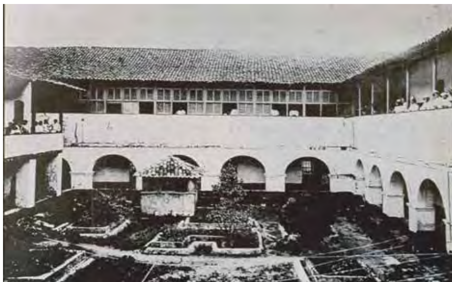
Figura 4 - Hospital de Isolamento do Maranhão, 1904.
