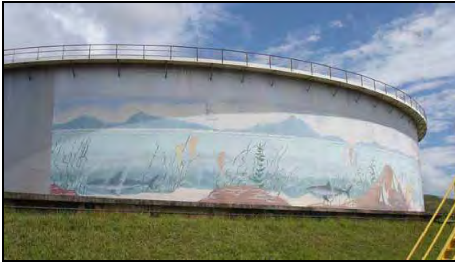
Figura 4. Tanque nº 3213, armazenamento da água de produção na entrada da Estação de Tratamento de Efluentes (ETE) do Terminal Marítimo de São Sebastião (TEBAR), SP.
