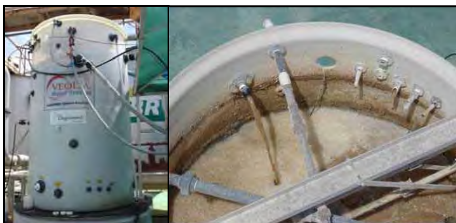
Figura 9. Reator biológico e detalhe do retorno do lodo na região superior do reator, Terminal Marítimo de São Sebastião (TEBAR), SP.
