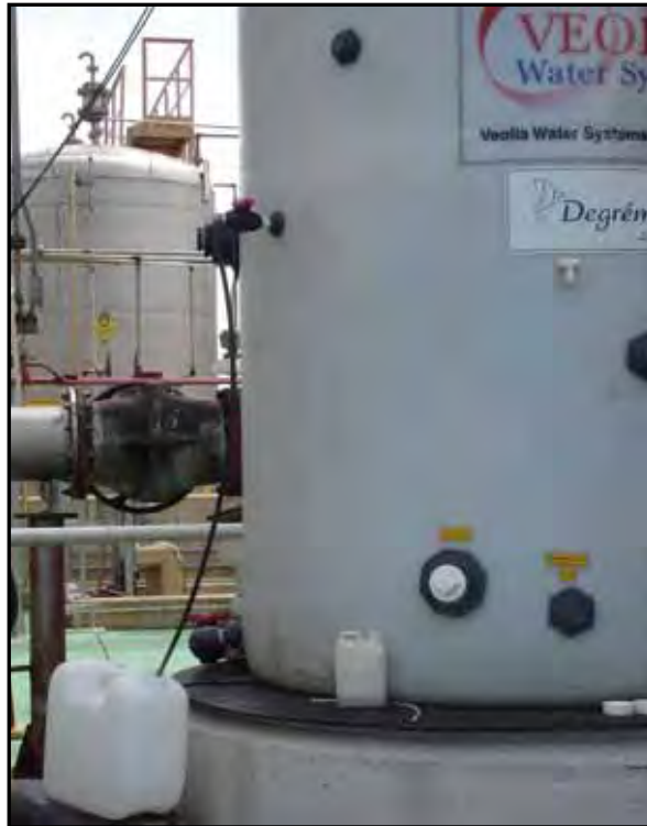
Figura 10. Coleta do lodo gerado pelo tratamento biológico da água de produção no Terminal Marítimo de São Sebastião (TEBAR), SP.
