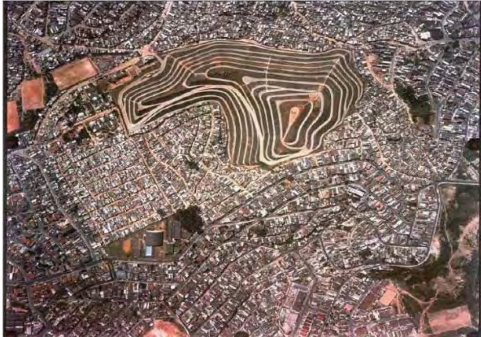
Figura 37 – Aterro Desativado de Inertes de Itatinga – Vista aérea
