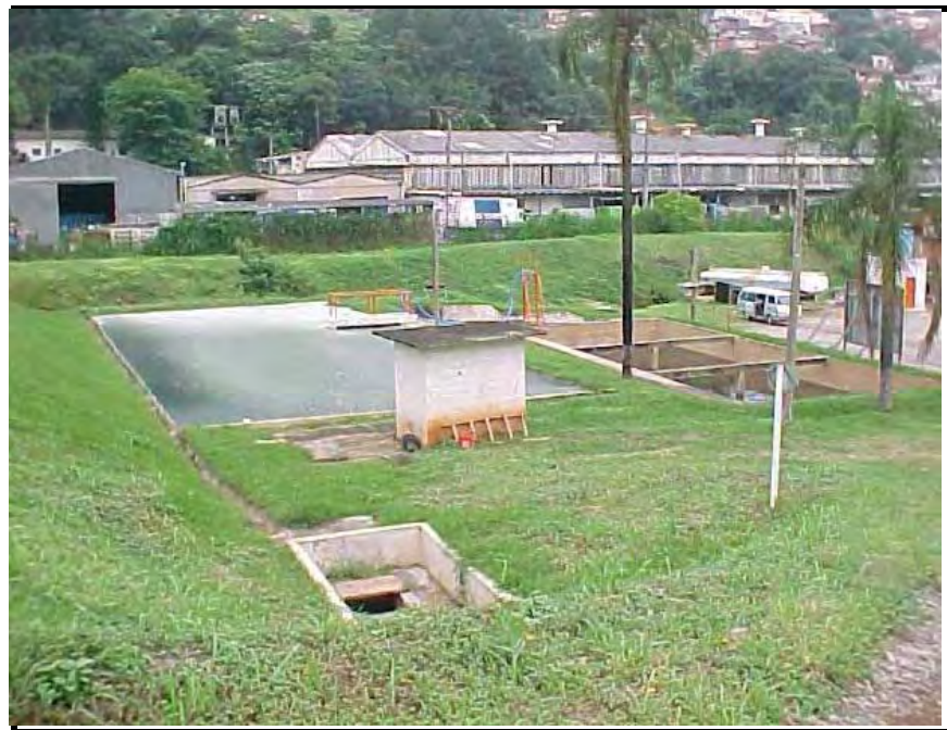
Figura 13 - Aterro Desativado de Santo Amaro - Drenos de Gás
