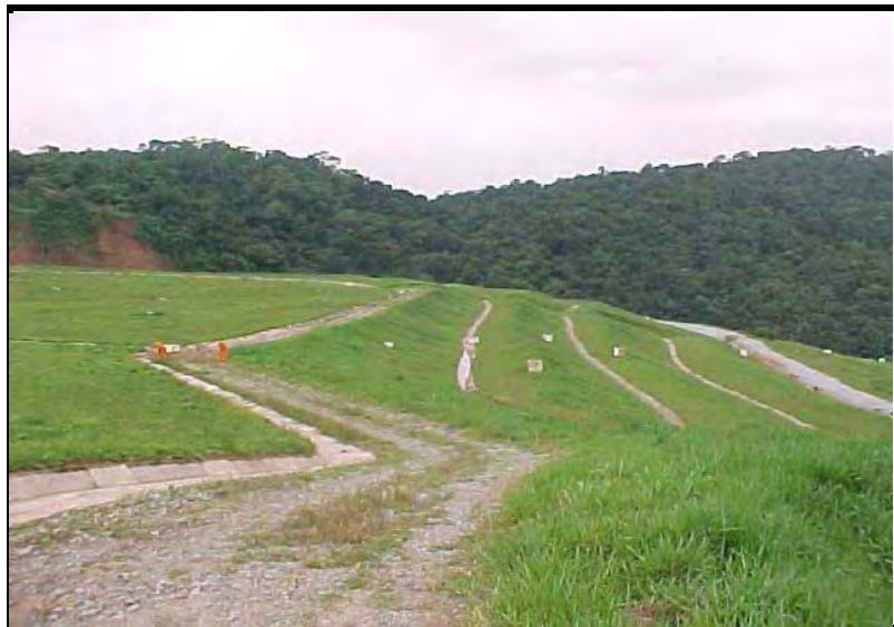
Figura 15 – Aterro Desativado de Santo Amaro – Piezômetro (controle da estabilidade do aterro)
