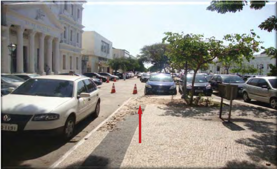
Foto 28: Barreira arquitetônica/passagem de pedestre na Praça D. Pedro II. Fonte: CUNHA, H.W.A.P, 2010.
