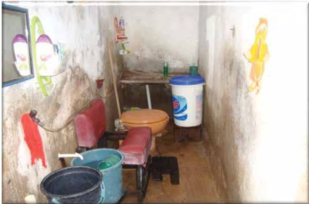
Foto 15: Banheiro sem nenhuma adaptação. Fonte: CUNHA, H.W.A.P, 2011.
