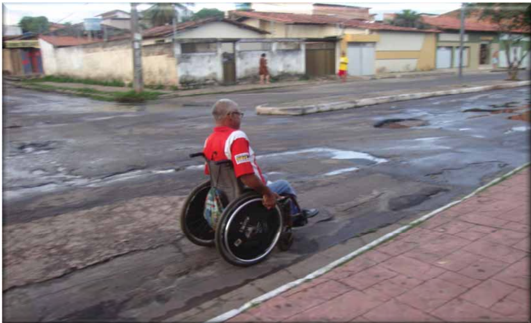
Foto 29: Barreira arquitetônica/calçada sem rebaixamento/Angelim. Fonte: CUNHA, H.W.A.P, 2010.
