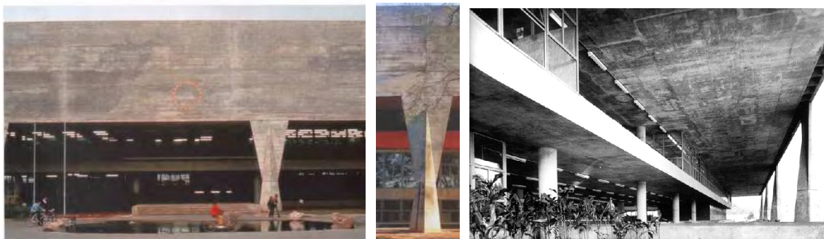
Fotos 13, 14 e 15: Detalhe do Pilar da Fau - “O ponto de apoio negando a gravidade”.
