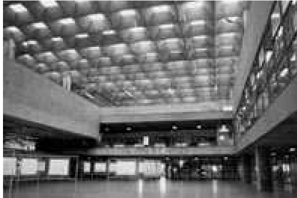
Foto 3: Prédio da Fau USP - o vão central iluminado estruturando os ambientes em sua volta. O espaço interno com as características do externo, remete ao Panteão Romano.
