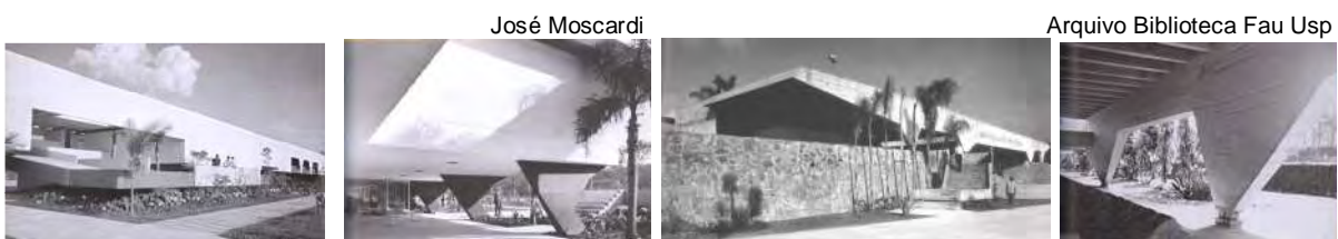
Fotos 34 e 35: Vestiários do São Paulo Futebol Clube. Fotos 36 e 37: Garagem Santa Paula, a grande cobertura e o desenvolvimento estrutural da edificação. Uma pesada estrutura apoiando-se em pequenos pontos.
