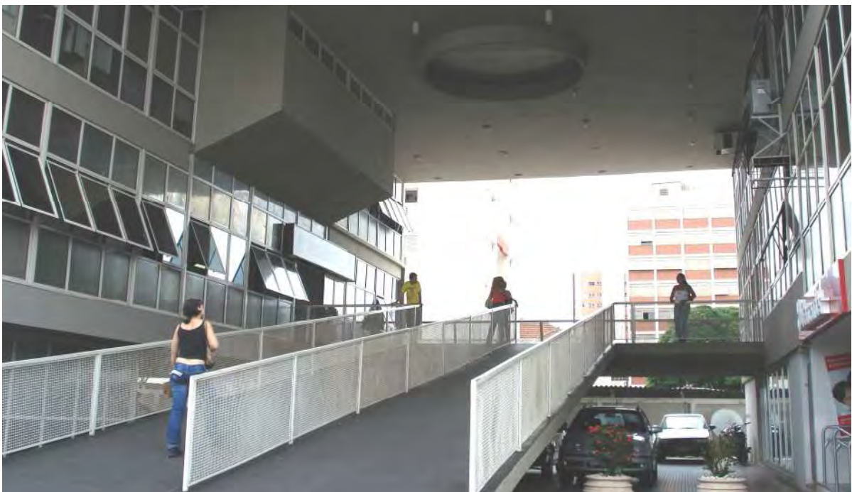
Foto 105: O Hall como acesso, circulação e permanência.
