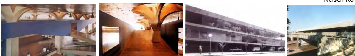
Fotos 51, 52, 53 e 54: Rodoviária de Jaú, uma cobertura sobre os acontecimentos do lugar: o existente (caminho de pedestres) e o projetado (Terminal de Ônibus). O pilar, desenho resultado da necessidade técnica associada à iluminação natural.
