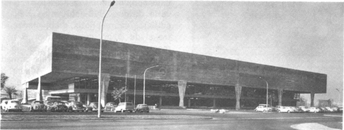
Foto 33: Fau USP, a caixa de concreto e os sutis pontos de apoio.
