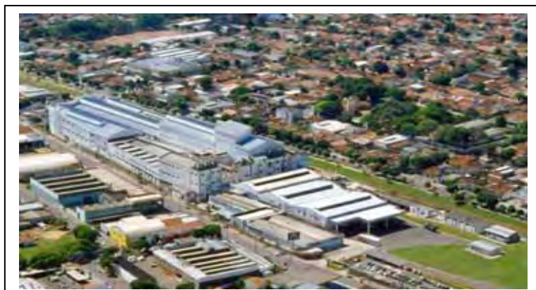
FOTO 8: Vista aérea da fábrica da Nestlé, unidade de Marília – SP. In: Barbosa et al, 2008, p. 66.
