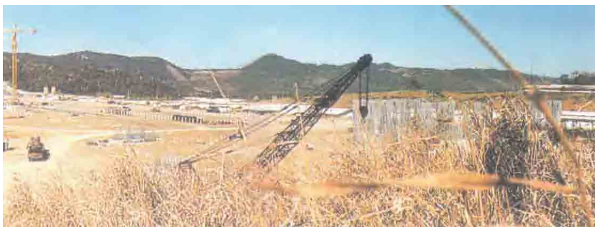
Figura 68 – Início do processo de implantação da fábrica de cimento da Camargo Corrêa Cimentos. Fonte: Behr (2001)
