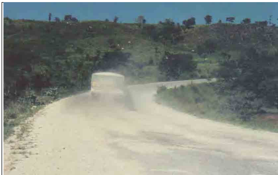
Figura 63 - Infra-estrutura viária em péssimo estado de conservação. Foto: Almeida (2004)
