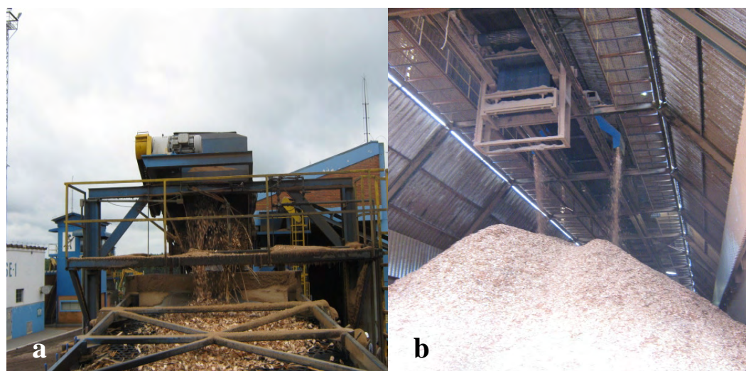
Figura 6 – Classificação e armazenamento da mistura de cavacos. a) peneira vibratória de classificação; b) Pátio coberto de armazenamento da mistura de cavacos.
