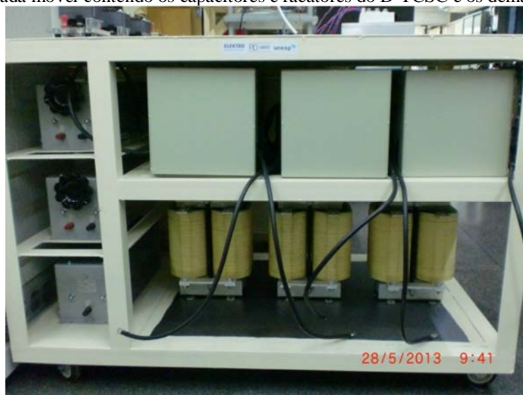
Figura 45- Bancada móvel contendo os capacitores e reatores do D-TCSC e os demais equipamentos.
