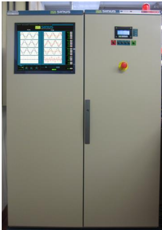
Figura 47 – Filtro ativo de potência paralelo.
