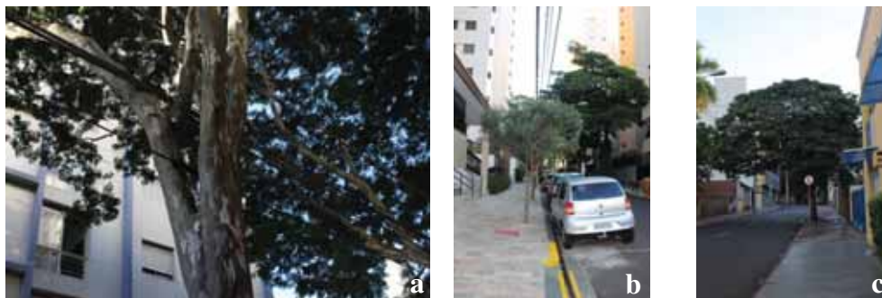
Figura 9. Problemas com fiação elétrica nas vias inventariadas do quadrilátero central de Ribeirão Preto, SP. Atual (a); Potencial (b); e Ausente (c).
