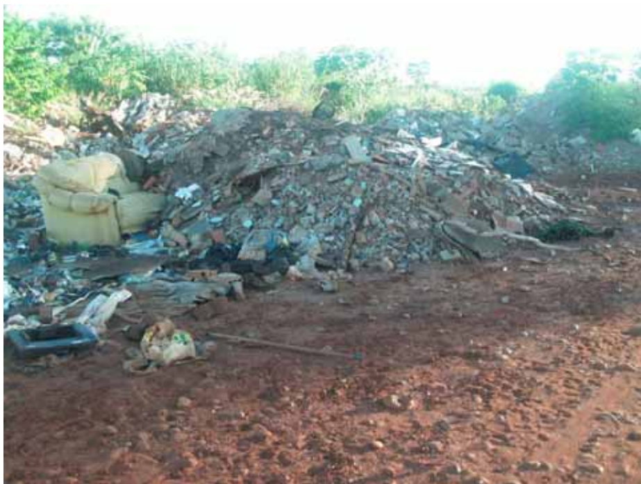
Foto 4- Depósito de lixo da construção civil.
