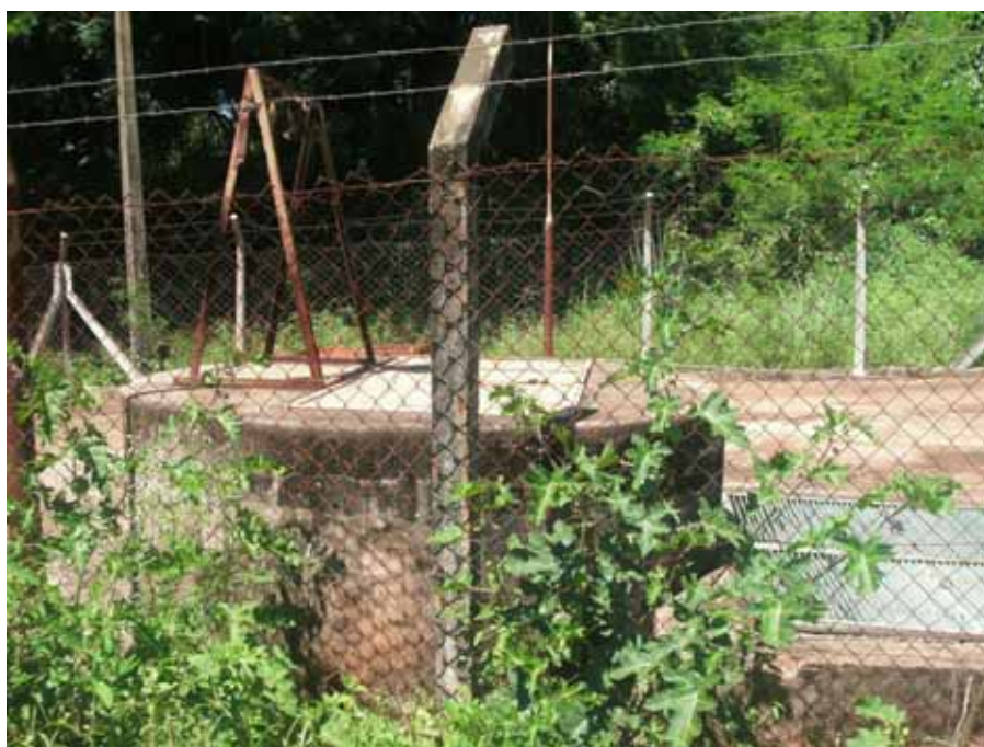
Foto 12- Canalização de esgoto.
