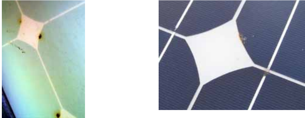
Figura 5.7: Pontos quentes em módulos fotovoltaicos.
