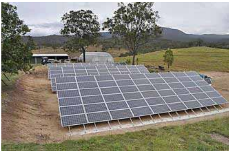
Figura 5.11: Painéis fotovoltaicos instalados no solo.
