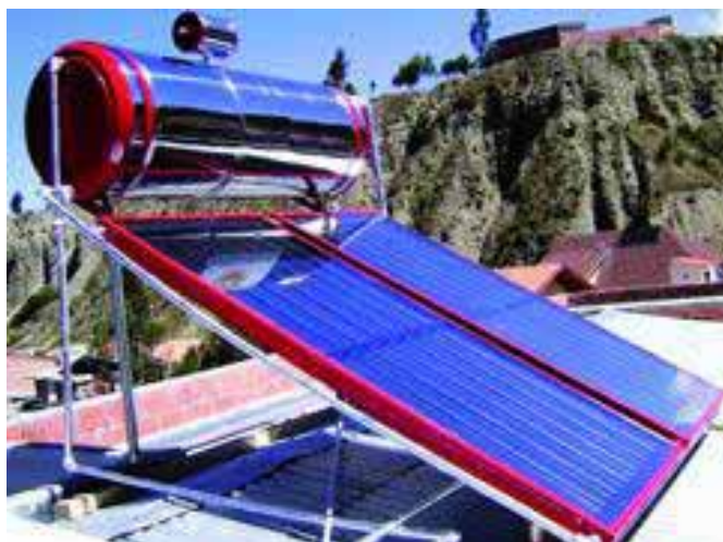
Figura 6.1: Sistema termosolar de aquecimento de água.
