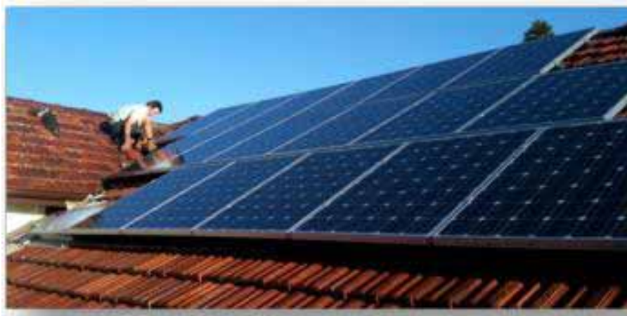
Figura 5.10: Painel fotovoltaico instalado em telhado.
