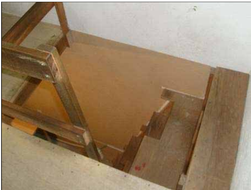
Foto 07. Oficina da E3 em sala adaptada. Escada improvisada para criar um piso superior. Por Camilla Marcondes Massaro.
