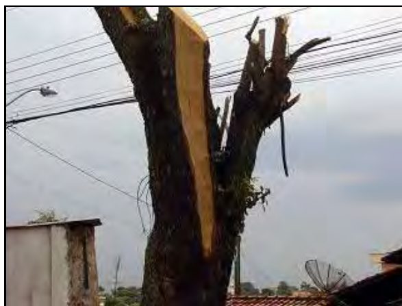
Figura 4 – Poda drástica feita em árvore para evitar danos à rede elétrica
