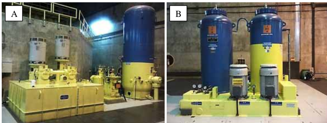
Figura 52 – Tipos de reguladores presentes no piso dos geradores: A) RV presente nas quatro primeiras unidades geradoras e B) RV para presente nas demais unidades geradoras.
