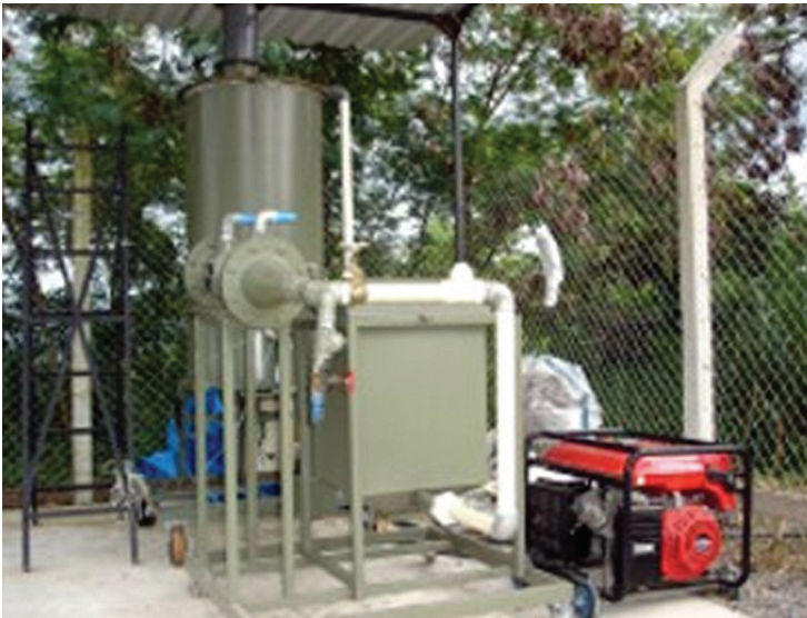
Figura 19.1 – Sistema de gaseificação de biomassa construído no Lose-FEG-Unesp.
