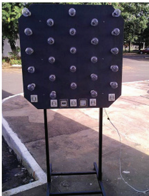
Figura 27.27 – Painel de cargas utilizado nos testes do grupo gerador
