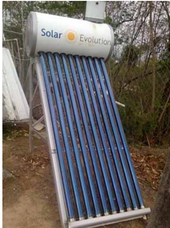
Figura 30 – Foto do sistema de aquecimento solar com módulos de tubos de vidro a vácuo instalado no Centro de Energias Renováveis da Unesp, em Guaratinguetá, SP.
