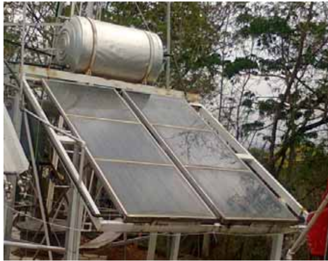
Figura 29 - Foto do aquecedor solar de água com coletores solares planos instalado no Centro de Energias Renováveis da Unesp, em Guaratinguetá, SP.
