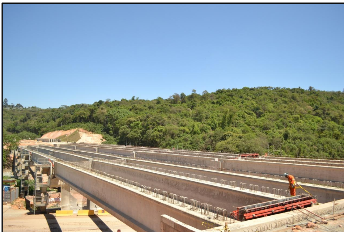
Figura 9. Obra de construção do trecho norte do Rodoanel próxima aos limites do Parque. Registro feito nas proximidades do núcleo Cabuçu.
