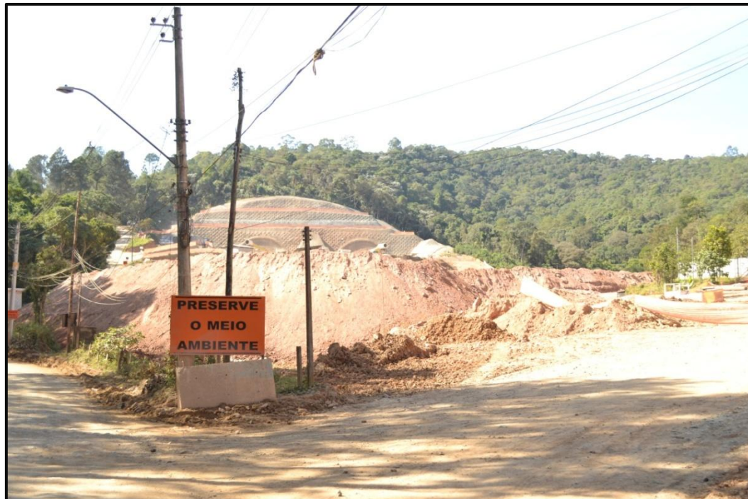
Figura 8. Obra de construção do trecho norte do Rodoanel próxima aos limites do Parque. Um dos principais empreendimentos do governo do Estado de São Paulo em execução durante a realização dessa dissertação. Registro feito nas proximidades do núcleo Cabuçu. Atentar para a placa: “PRESERVE O MEIO AMBIENTE”.
