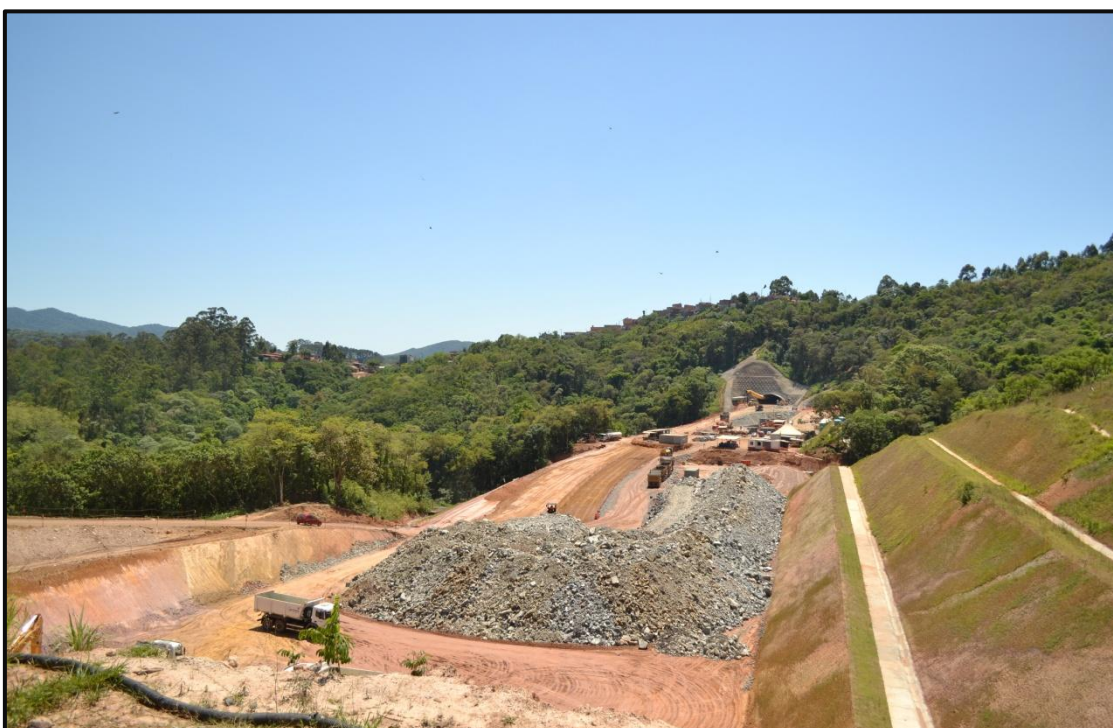
Figura 10. Obra de construção do trecho norte do Rodoanel próxima aos limites do Parque. Registro feito nas proximidades do núcleo Cabuçu.
