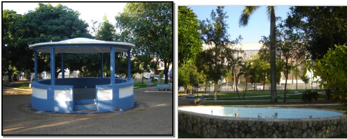
Figura 52 - Coreto em alvenaria e concreto e a fonte luminosa. Fotos de 2009.
