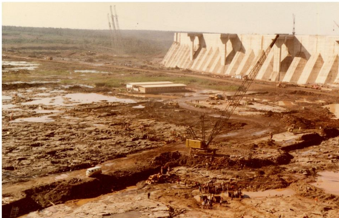
Figura 69: Construção da Usina de Itaipu em 1982
