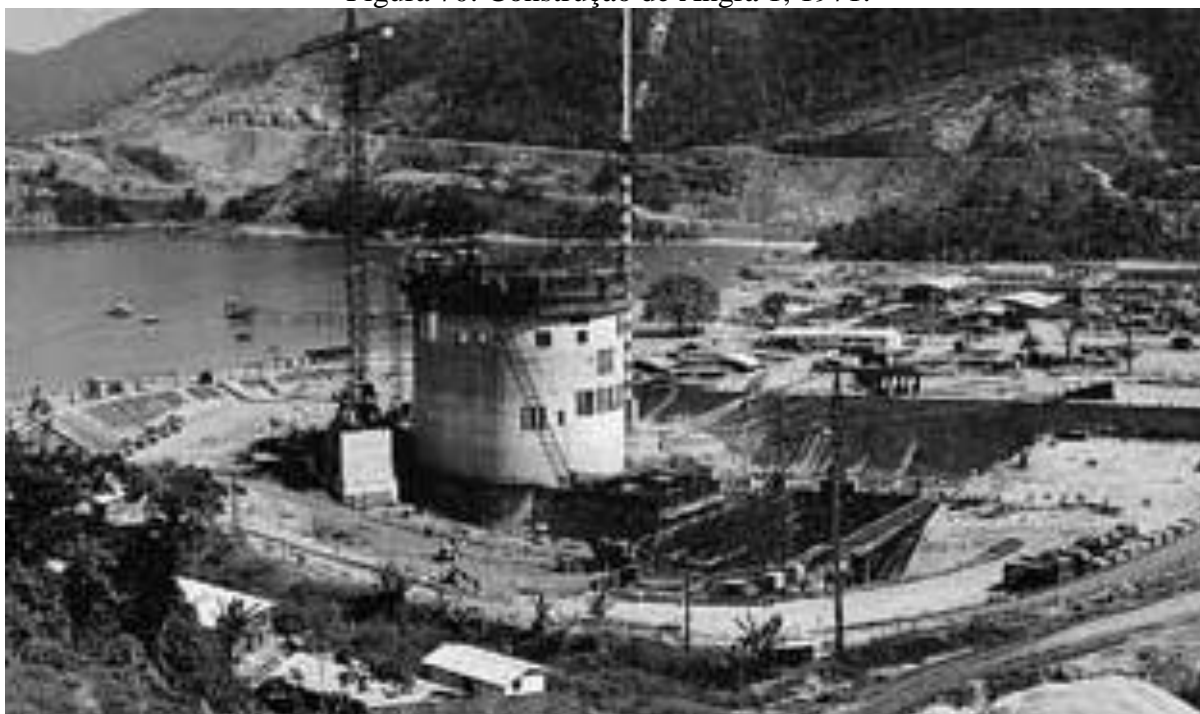
Figura 70: Construção de Angra 1, 1971.
