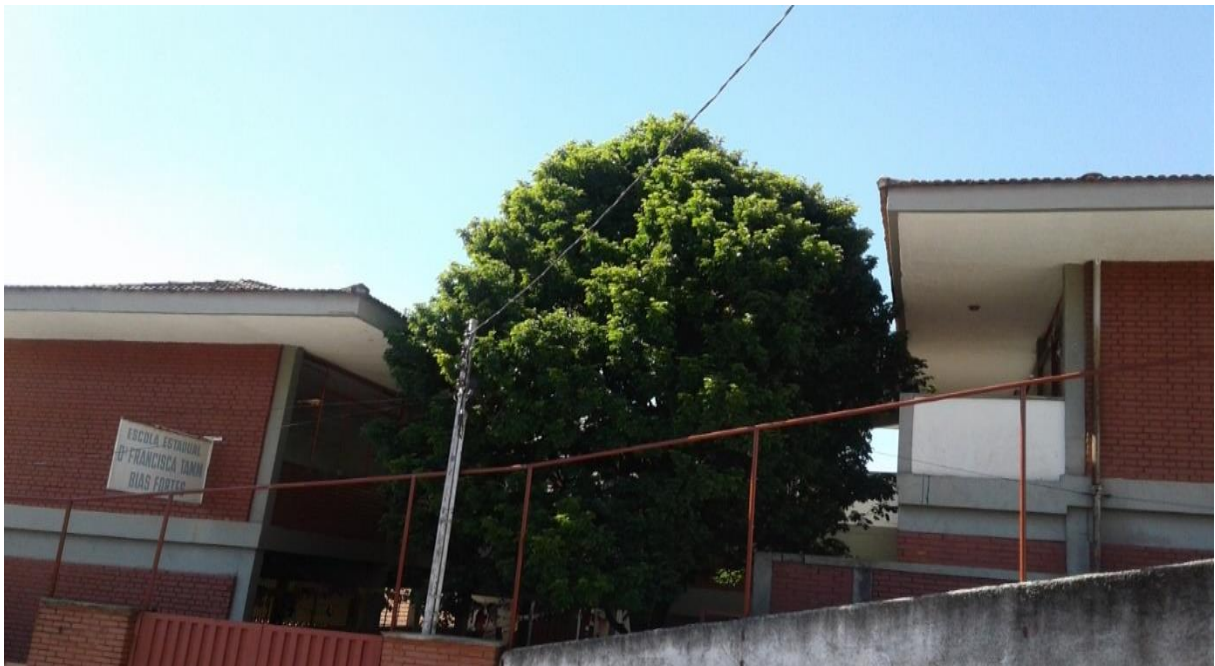
Figura 8 - Fachada da E. E. Dona Francisca Tamm Bias Fortes. Fonte: O autor.
