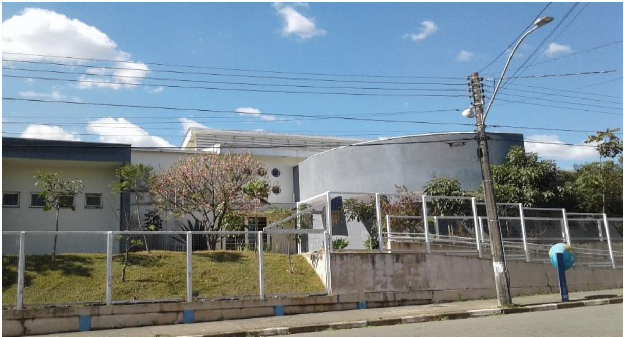
Figura 7 - Fachada da E. E. Ensino Fundamental e Médio. Fonte: O autor.
