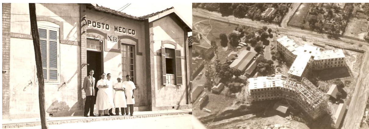
Figura 67. Posto Médico da NOB e Hospital de Base em construção
