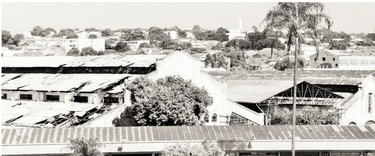
Figura 64. Situação atual do telhado das oficinas da EFNOB
