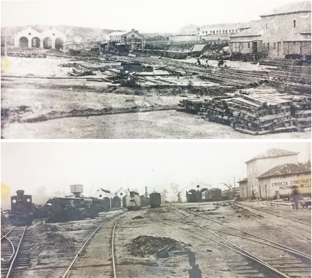
Figura 23. Antigas oficinas da NOB, que foram substituídas e demolidas
