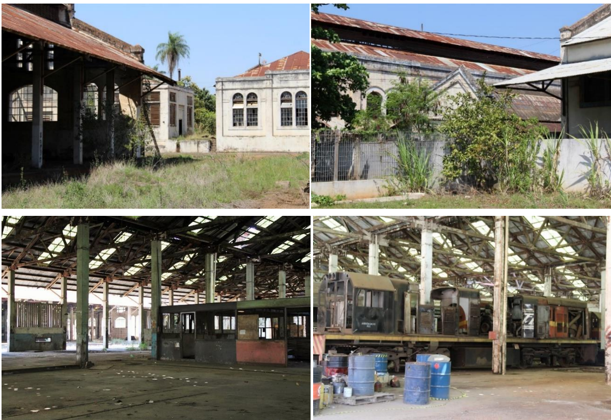
Figura 43. Situação atual do complexo ferroviário
