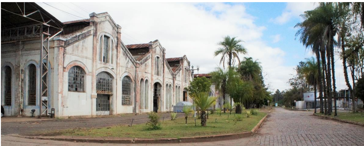
Figura 42. Situação atual do patrimônio (fachada das Oficinas Gerais)
