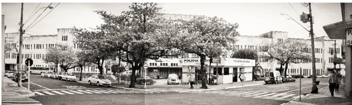
Figura 70. Estação ferroviária da EFNOB encoberta pelas árvores da praça Machado de Melo
