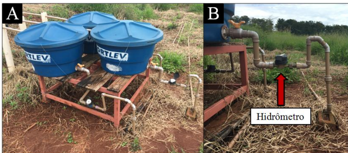
Figura 15 – A) Reservatórios de coleta do efluente tratado; B) Hidrômetro.
