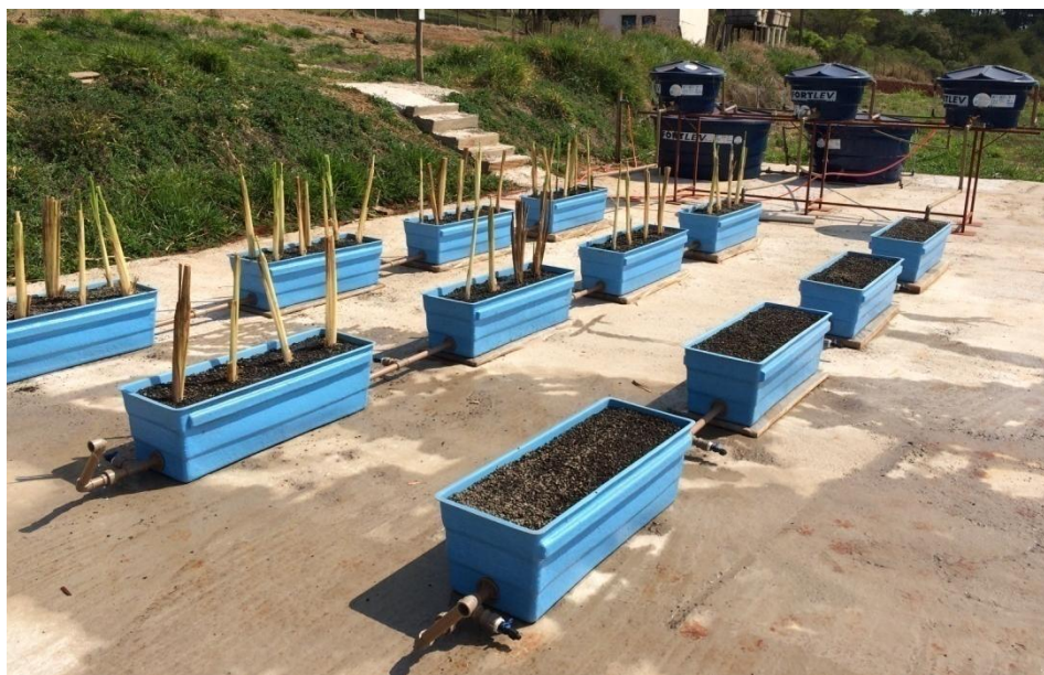
Figura 11 – Sistema de tratamento no dia do plantio das macrófitas.
