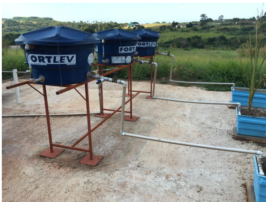
Figura 14 – Caixas de distribuição de efluente.
