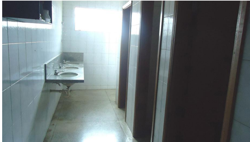
Figura 8 – Banheiro da escola E4
