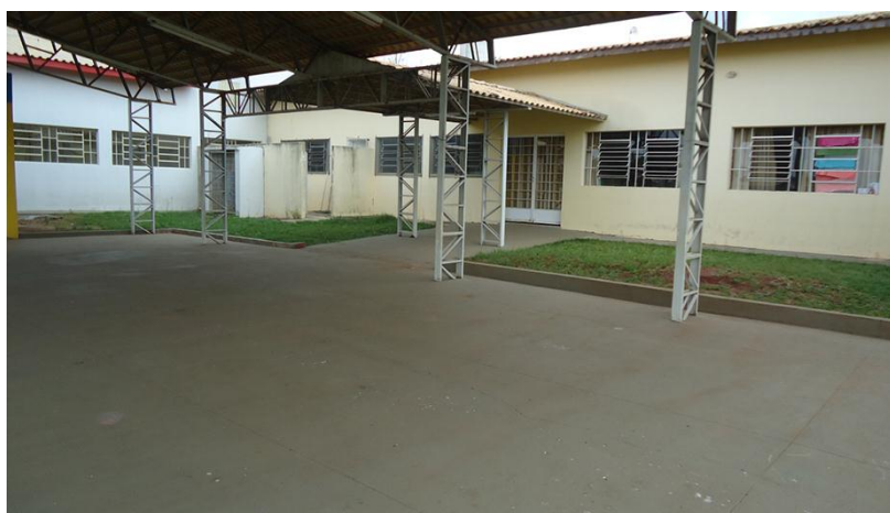
Figura 6 – Pátio coberto da E5
