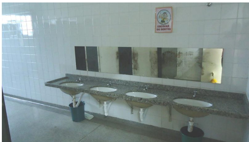
Figura 9 – Banheiro da escola E5
