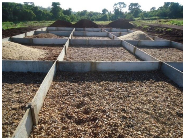
Figura 5. Camada de cascalho de areia utilizada como “colchão drenante”.
