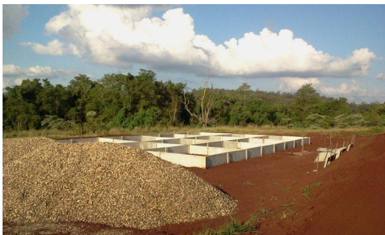
Figura 3. Estruturas de concreto como divisórias para os tratamentos.
