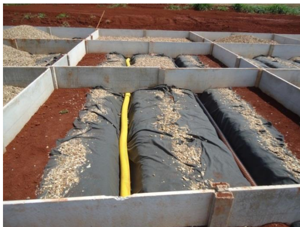
Figura 4. Implantação do sistema de drenagem: tubo drenante e manta geotêxtil.
