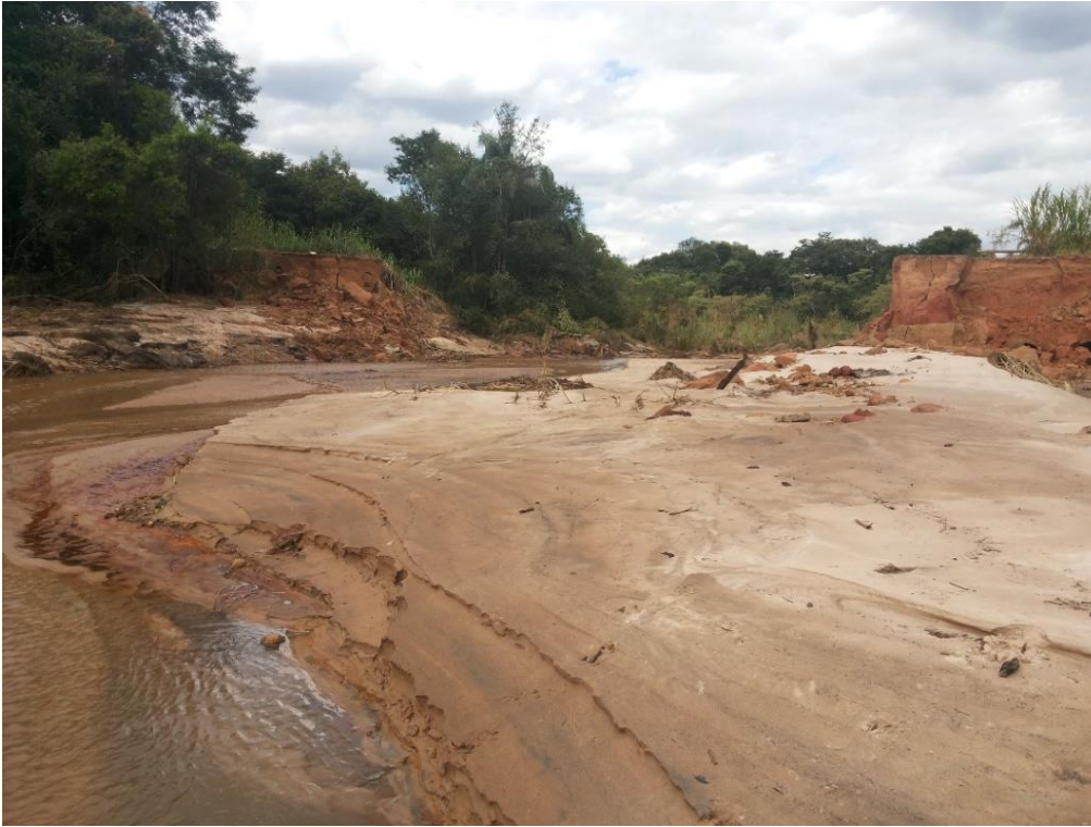
Figura 23– Ponte de acesso destruída pela vazão das águas no regime de chuvas.
