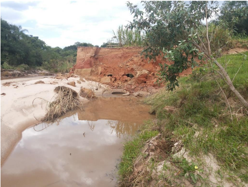
Figura 24 – Tubulações destruídas, demonstrando que o curso do rio passava por elas.
