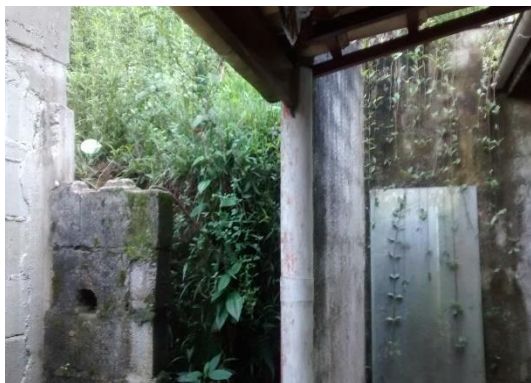
(a) residência de baixo padrão estrutural próximo a talude
