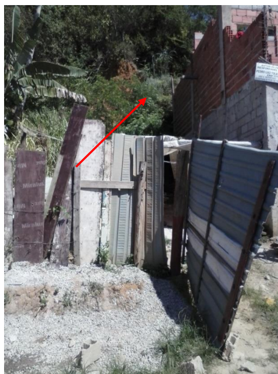
(b) moradia próxima a talude de corte em área inadequada
