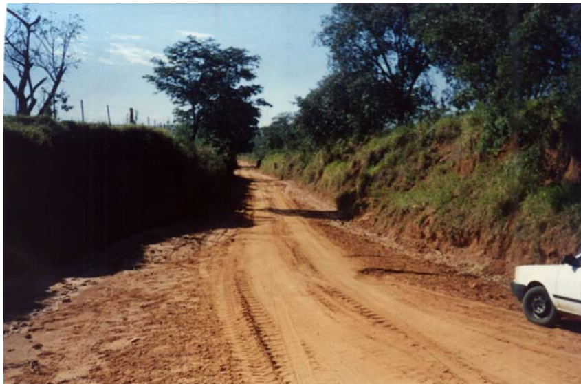
Figura 2. Trecho da estrada PLA – 06 antes do processo de intervenção
