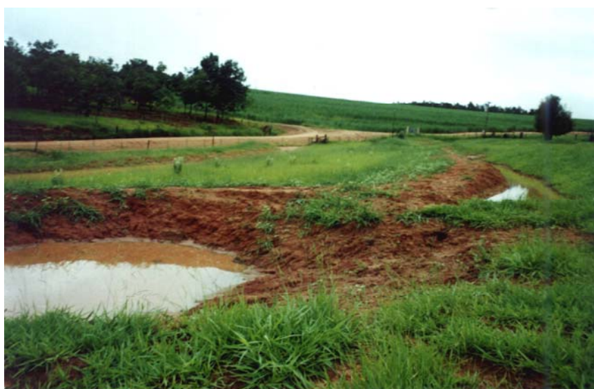
Figura 9. Terraço com gradiente em detalhe a ponta escoando água para a bacia de captação na PLA-06
