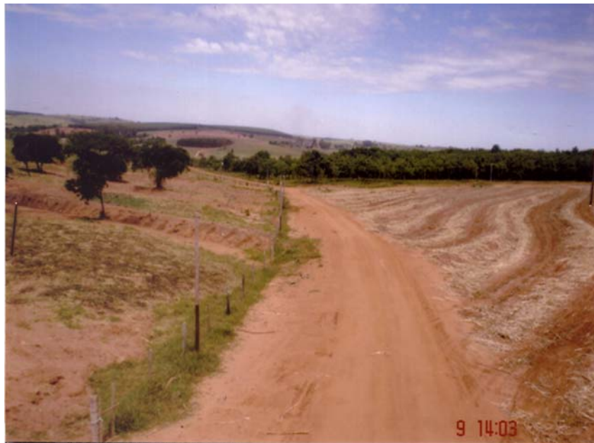
Figura 8. Abaulamento transversal e dispositivos de drenagem do trecho da estrada PLA-06, objeto de processo de intervenção corretiva
