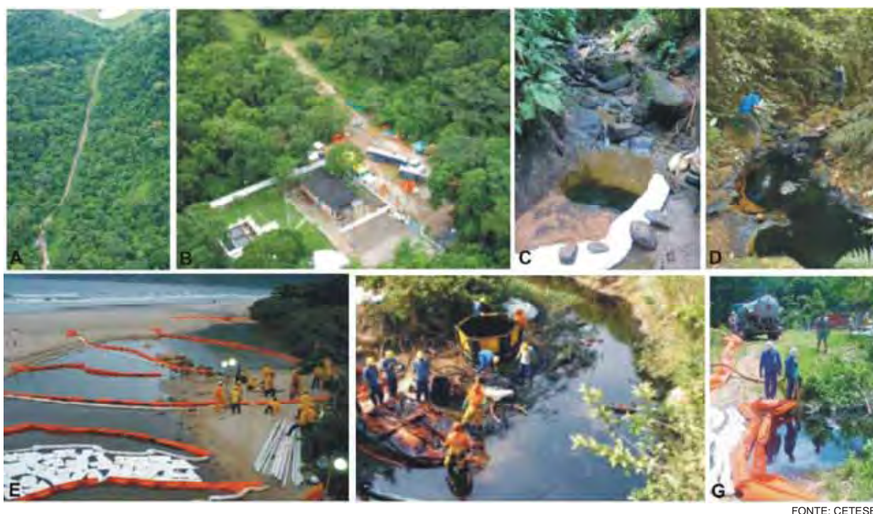
Figura 3. Acidente do oleoduto OSBAT no rio Guaecá, 18 de fevereiro de 2004. A. Faixa do oleoduto OSBAT inserido na Serra do Mar; B. Estação de Captação de Água do rio Ribeirão SABESP; C. Mancha de óleo próxima a nascente do rio Guaecá; D. Grande volume de óleo visualizado no rio Guaecá no momento da detecção do acidente; E. Cenário acidental mostrando operações de emergências para contenção do óleo vazado. F. e G. Operações de remoção do óleo do rio Guaecá.
