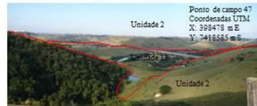
Vista panorâmica da Rodovia Carvalho Pinto (SP-070), no sentido noroeste-sudoeste. As vertentes retilíneas e côncavas da Unidade 2, neste cenário, limitam-se com a planície aluvionar da Unidade 13.
