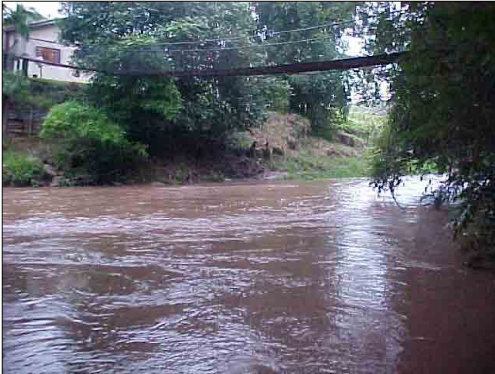
Figura 5.30 - Foto da ponte pênsil no camping Bambuzinho.
