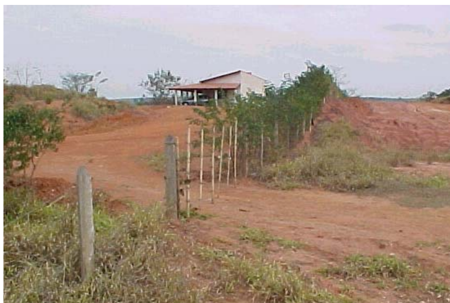
Foto 19: Pilha de bota-fora classificada como camada construída do tipo espólio. Notar casa instalada no alto do bota-fora. (Ponto EG 114)
