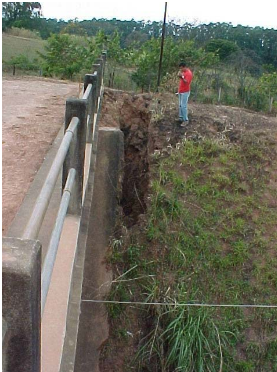
Foto 11: Processos erosivos instalados em beira de ponte sobre a linha férrea. (ponto EG 108).
