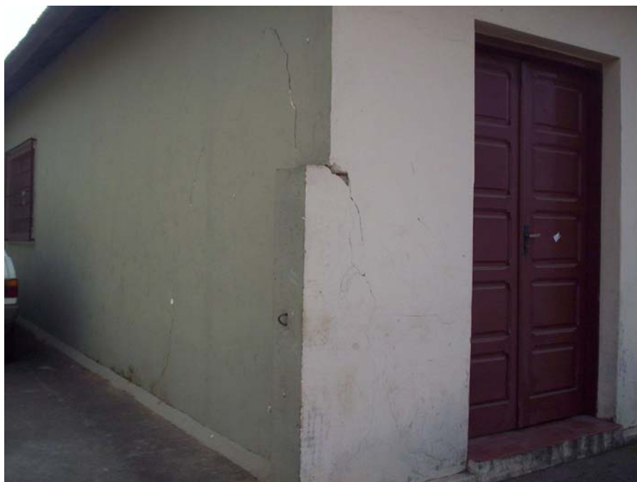
Foto 15: Trincas nas paredes de casas e muros são comuns nesta unidade (ponto EG 111).
