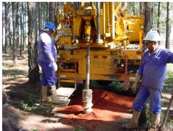
Foto 1. Equipamento Hollow Stem Auger utilizado para instalação dos poços e piezômetros.
