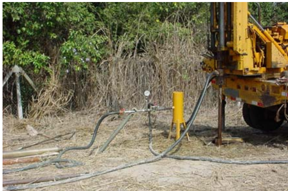
Foto 2. Realização de ensaio de perda d'água sob pressão.
