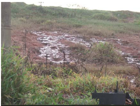
Figura 5.31: Chorume aflorando através da parede externa da cava de resíduos e migrando em direção à estrada não pavimentada.
