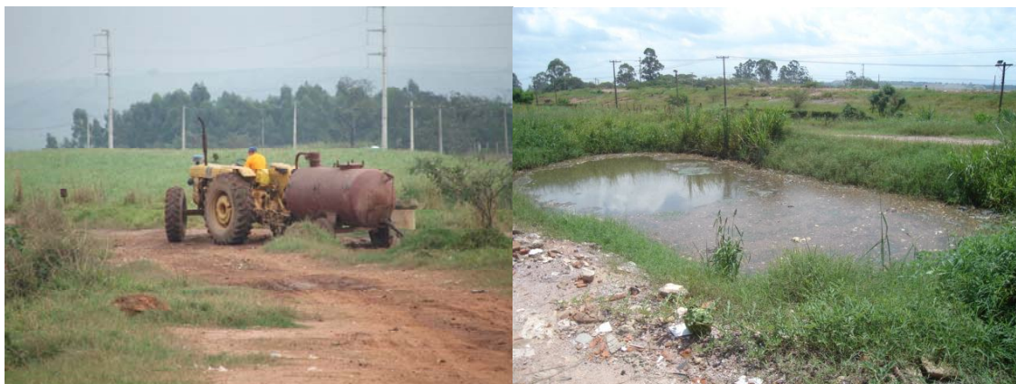
Figura 1.3: À direita: transporte de chorume entre os dois aterros; à esquerda: lagoa do sistema de recirculação de chorume do aterro controlado de Rio Claro (SP).
