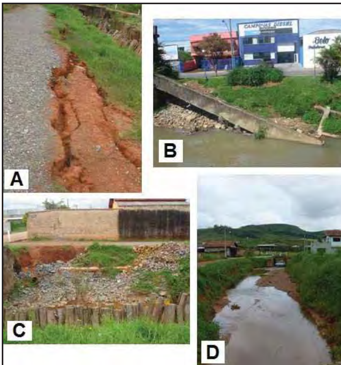
Figura 26 - A. Rachaduras na rua em decorrência da erosão das margens de um córrego no Jd. Kennedy; B. Erosão na margem do Ribeirão dos Poços; C. Erosão das margens e material arrastado por enchente em afluyente no Córrego das Vargens; D. Assoreamento em córrego próximo ao aeroporto.
