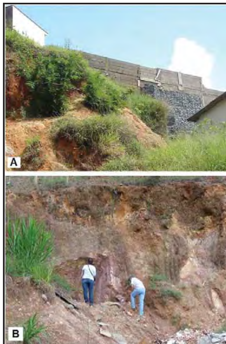
Figura 27 - A. Muro de gabiões amparando residência em corte instável de talude; B. Corte mal executado em encosta com depósito de talús gerando área de instabilidade.
