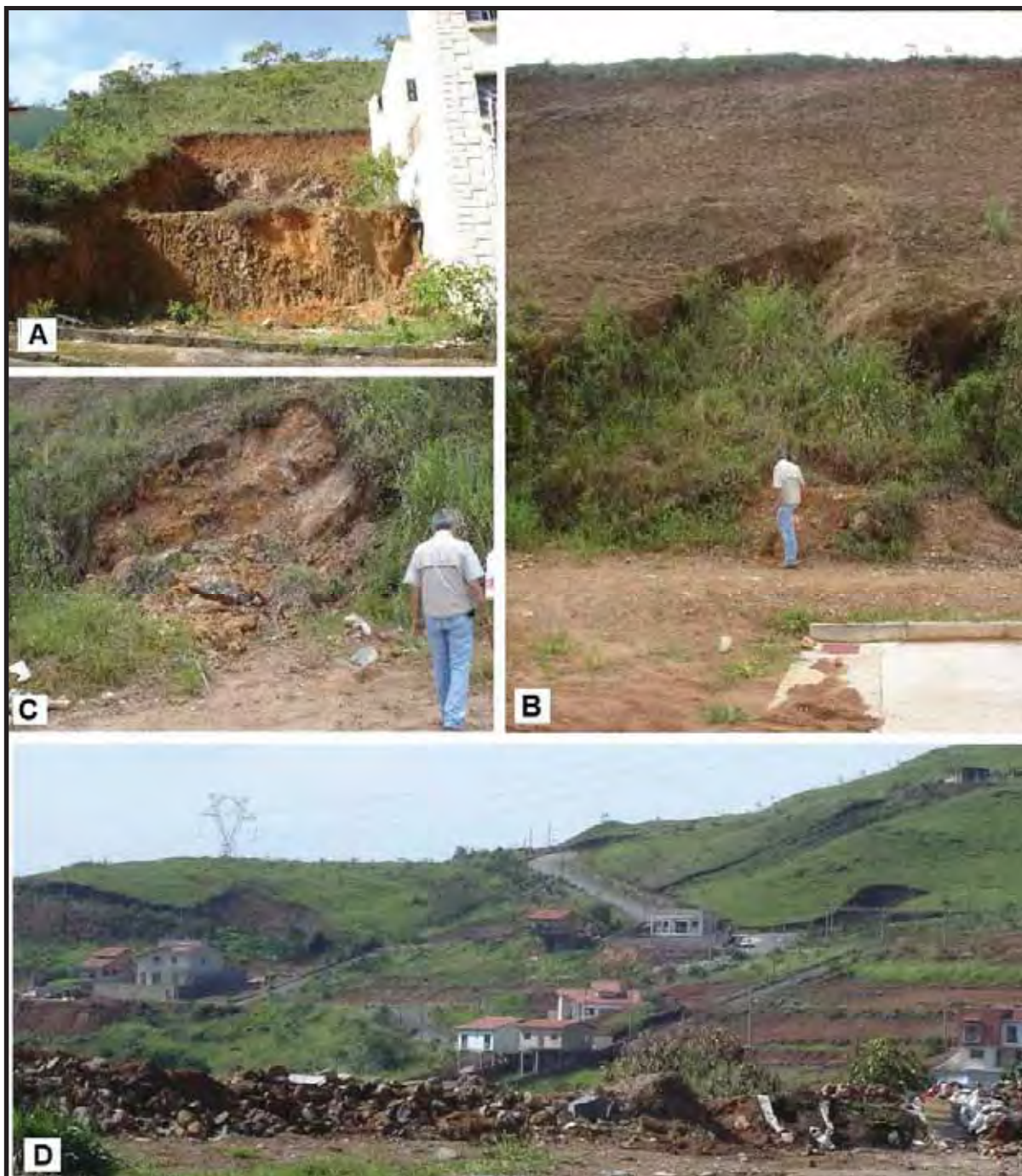
Figura 30 - A. Corte em talude para a construção de residência; B e C. Escorregamentos em cunha no sopé de morro; D. Diversos cortes e aterros para a construção civil.
