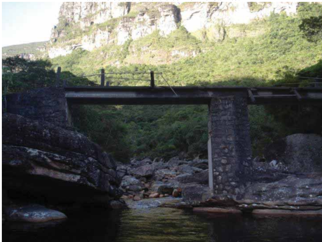
Figura 15 - Registro de processo de cheia. Ponte sobre o Rio Pati, localizada abaixo de seu encontro com o Rio Calixto.
