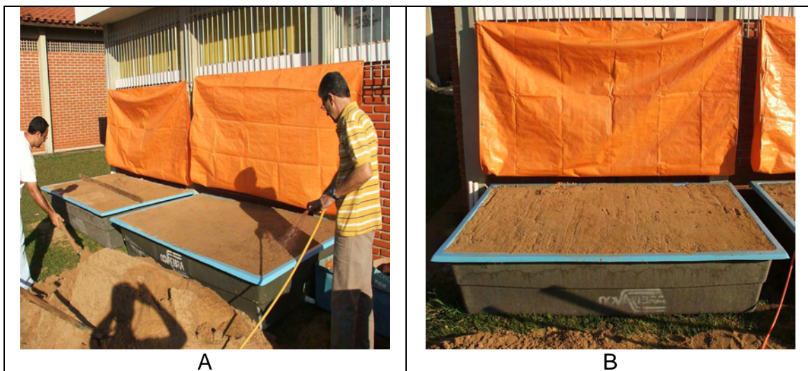
QUADRO 3.2 – Montagem do tanque de monitoramento. A) Nivelamento, B) Tanque finalizado com sedimentos.
