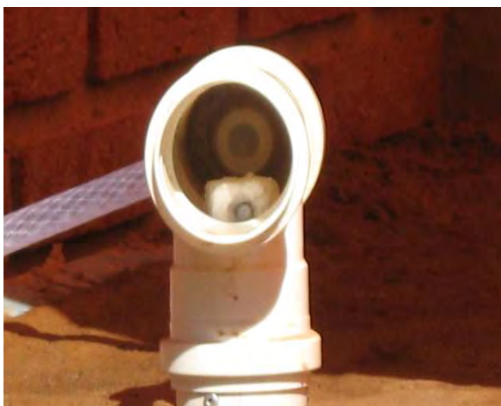
FOTO 3.8 – Detalhe da bóia
