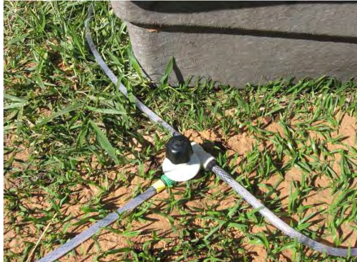
FOTO 3.5 - Torneira de distribuição
