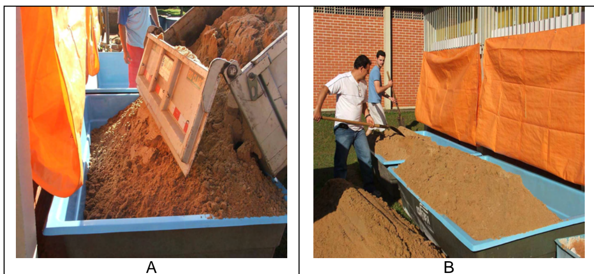
QUADRO 3.1 – Montagem do tanque de monitoramento. A) Deposição dos sedimentos, B) Uniformização.
